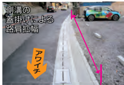
【側溝蓋がけ】 側溝の蓋がけにより、路肩幅を確保
